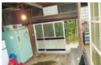
改修前の玄関土間
