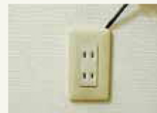
②カバーの間にドライバー等を差し込み、外します
